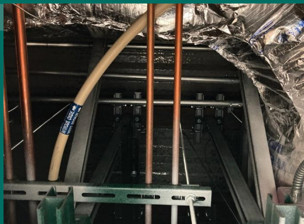
MediTrac® CMT dans le plafond d'une salle d'opération.
